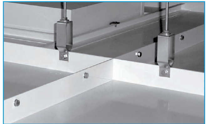
Abb. 5 Abhänger und verschraubte Deckenkassetten
